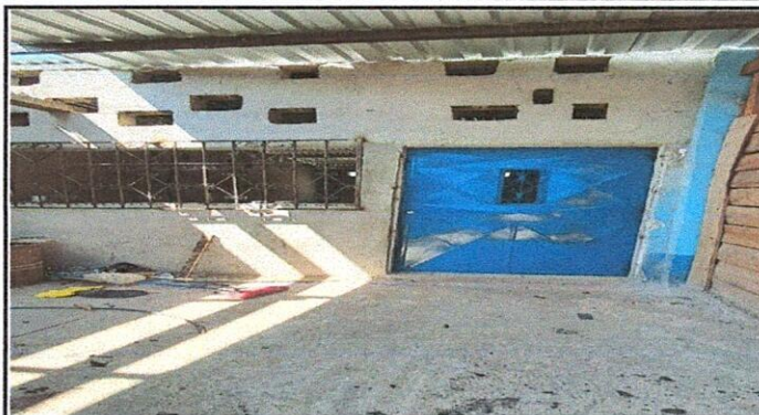
Foto 2: Remodelación de estructura de metal en puerta y ventana
