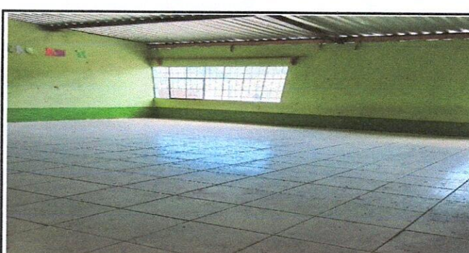
Foto 18: Sustitución de piso en aulas
