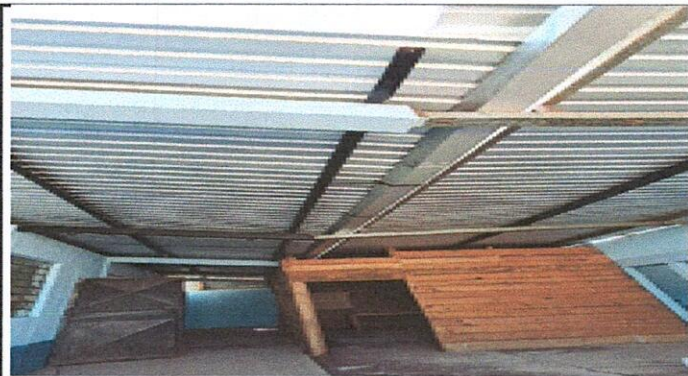
Foto1: Cambio de lámina troquelada Calibre 26
